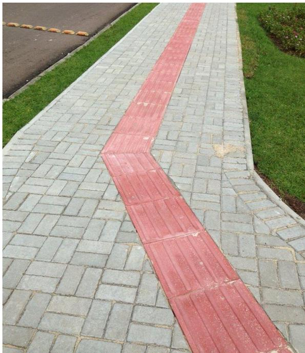
Figura 16 – Exemplo de calçada revestida de pisos intertravados (paver), com faixa permeável para locação de vegetação e de piso tátil, em Curitiba. Mostra a possibilidade de haver vegetação, permeabilidade, acessibilidade e aderência com baixo custo e benefício do material.
